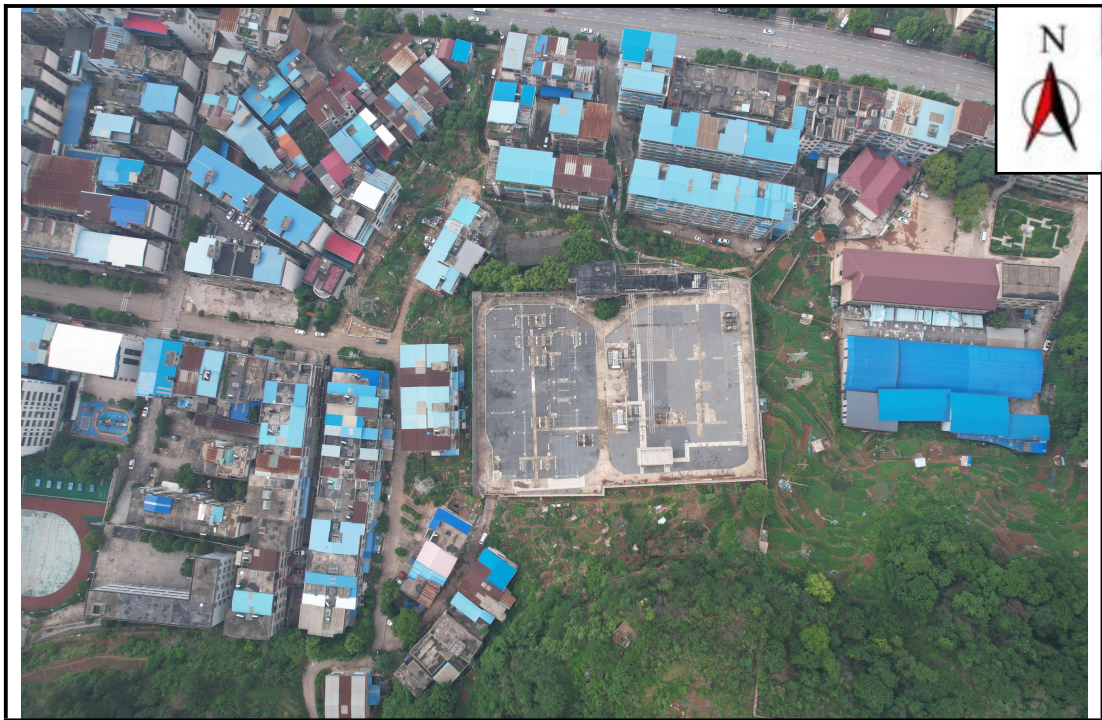
图 3-2 衡阳祁东洪桥 110kV 变电站周围环境现状
