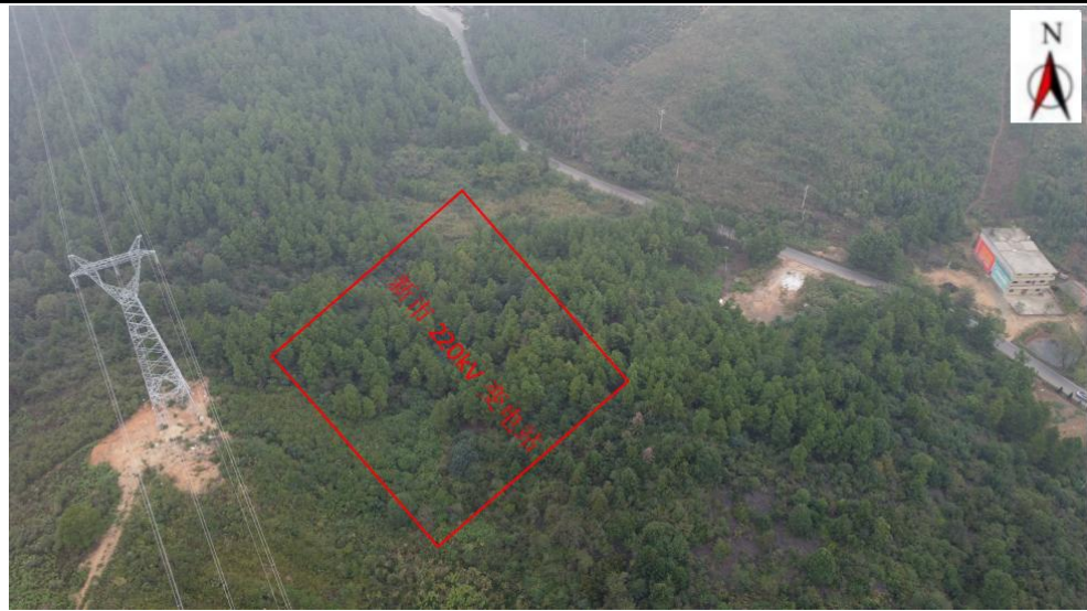
新市 220kV 变电站环境现状
