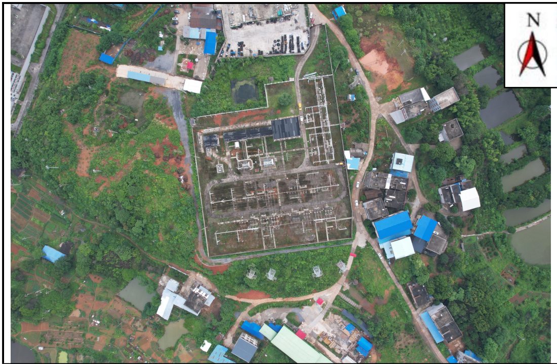
图 3-2 湖南衡阳耒阳柑梨冲 110kV 变电站周围环境现状
