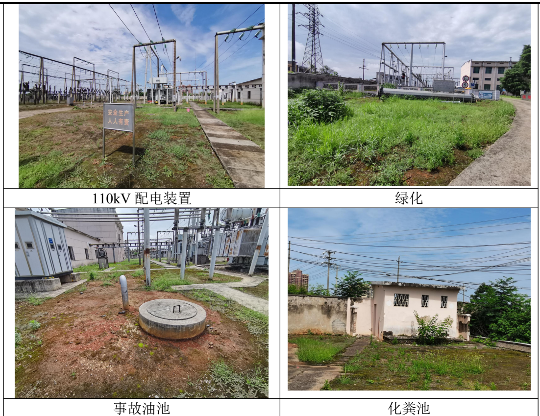
图 2-1 变电站站内环境现状
