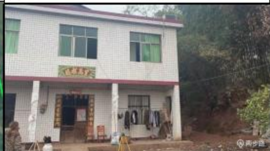
衡阳市蒸湘区雨母镇梓木村民房 7#
