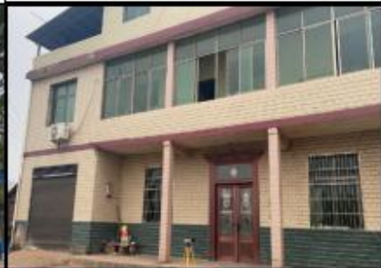
衡阳市蒸湘区雨母镇梓木村民房 6#
