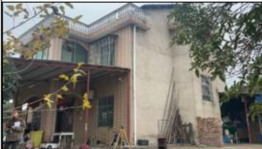
衡阳市蒸湘区雨母镇梓木村民房 5#
