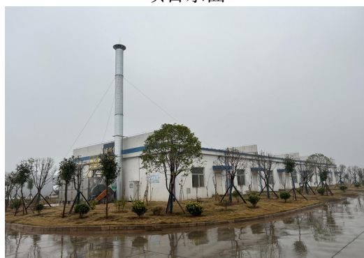
项目依托危废暂存间
